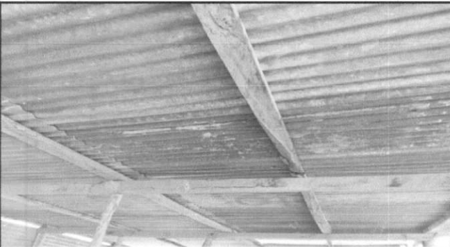
Foto 3: Sustrucción de láminas, por lámina troquelada aluzinc calibre 26
