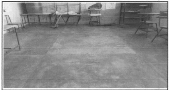
Foto 6: Sustrucción de piso de serámico
