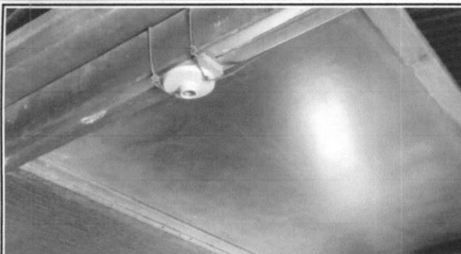
Foto 7: Sustrucción de plafoneras
